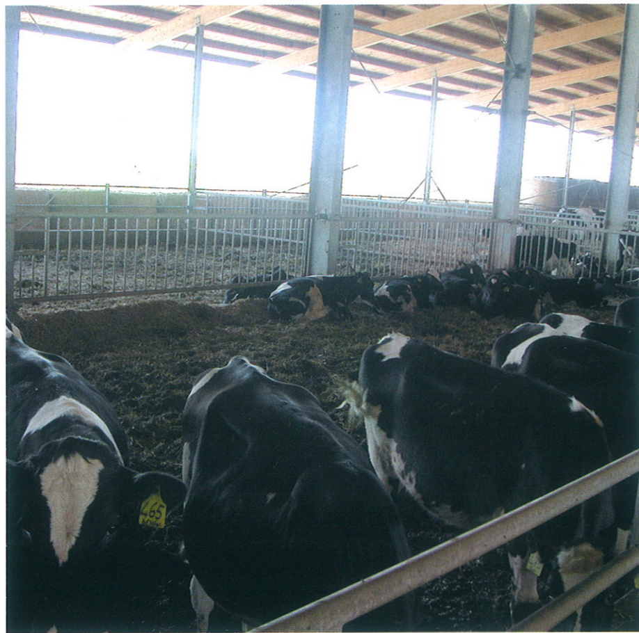
▼ Grazie alla possibilità di fissare i cancelli separatori ad ogni colonna è possibile ottenere la massima flessibilità nel numero e nell'ampiezza dei recinti.
