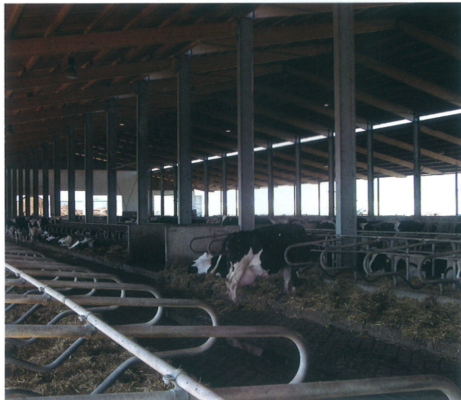
▼ Un'altra immagine della stalla, con in primo piano le cuccette e la pavimentazione a losanghe della corsia. Non ci sono ventilatori.
