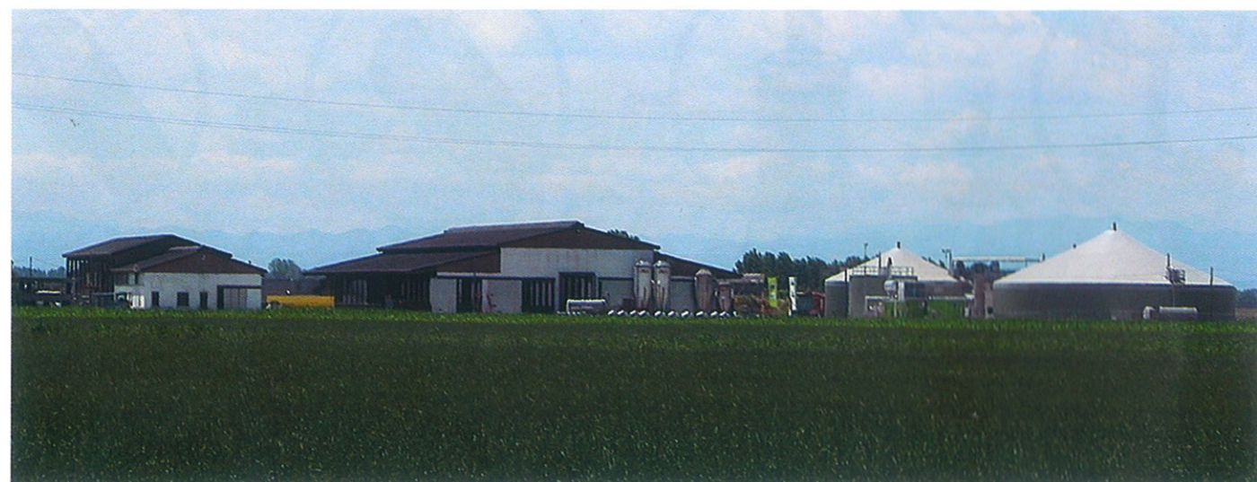
Una panoramica completa dell'azienda Antonio di Molinella, gestita da Pierluigi Pasini con i figli Stefano e Daniele. Da destra a sinistra si possono vedere, nell'ordine: i digestori dell'impianto di biogas da 1 megawatt (in primo piano il digestore secondario, dietro di esso i due digestori primari); la stalla in legno e il locale con sala di mungitura a giostra e, dietro, il fienile; l'essiccatoio da quarantotto balloni che funziona sfruttando il calore derivante dall'impianto del biogas. Il calore è usato anche per le necessità della sala mungitura e per il riscaldamento della casa di abitazione dei Pasini. L'azienda dispone di 180 ettari in un quadro unico. Si aggiungono altri due appezzamenti, per complessivi 260 ettari.
